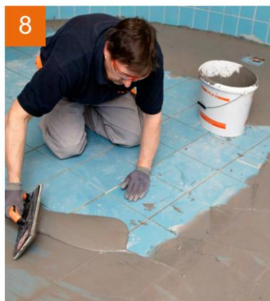
8 Am nächsten Tag erfolgt die Verfugung, zum Beispiel mit **PCI Durafug NT**. Die Fläche einschlammen ...
