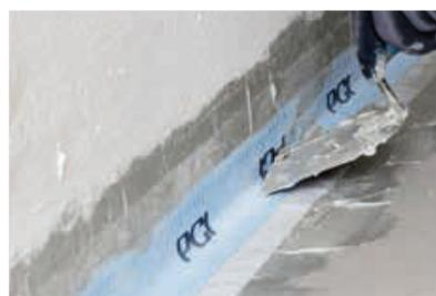
**PCI Pecitape 120** in **PCI Seccoral 2K Rapid** einlegen und danach mit zweiter Dichtschicht überstreichen
