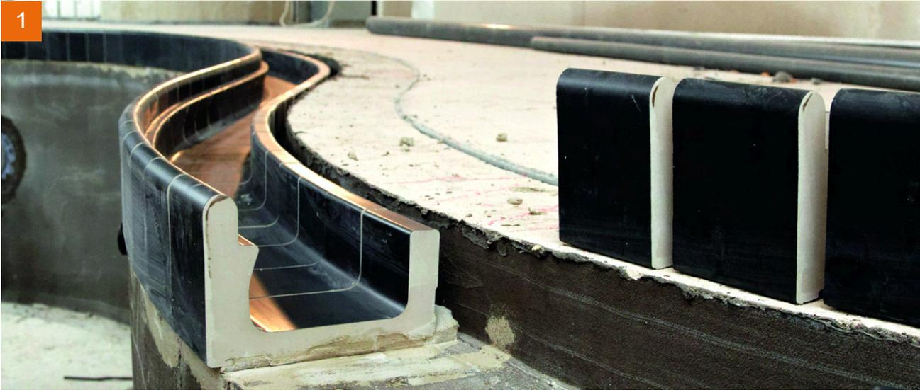
Rinnensteine zum Beispiel mit **PCI FT Klebemörtel** + **PCI Lastoflex** oder **PCI Durapox NT plus** hohlraumfrei setzen. Der Epoxidharz-Kleber hat eine kapillarbrechende Wirkung und kann im Dünn- und Mittelbettverfahren eingesetzt werden. Bei Kleberstärken > 5 mm **PCI Carrament grau** oder **PCI FT Ment** verwenden.
