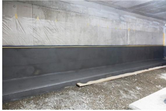
Die MDS **PCI Barraseal Turbo** erfüllt diese Anforderungen. Dabei werden zunächst Innenecken durch Anbringen einer Dichtkehle aus **PCI Polyfix Plus L** gerundet.
