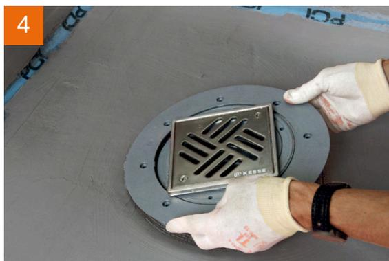
4 Klemmflansch aufsetzen und festschrauben.
