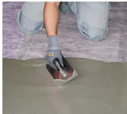
Mit einer Glättkelle verteilen (keine Rakel verwenden!)
