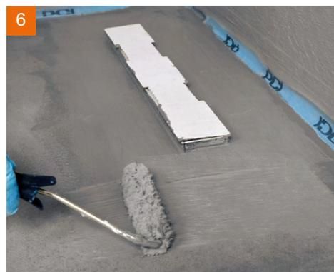
6 Anschließend die Entwässerungsrinne mit zwei Arbeitsgängen in die Flächenabdichtung einbinden.
