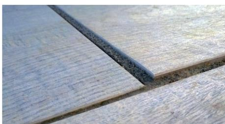
*Nachteil lose Verlegung: Schubkräfte der Platten führen zu Aufkantungen und Verschiebungen von Platten trotz anbetonierter Pflaster-Randeinfassung (zementär verfugt).*
