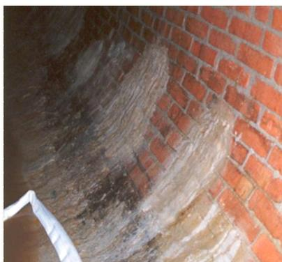
Bild: Ablagerungen in einem Abwasserkanal
