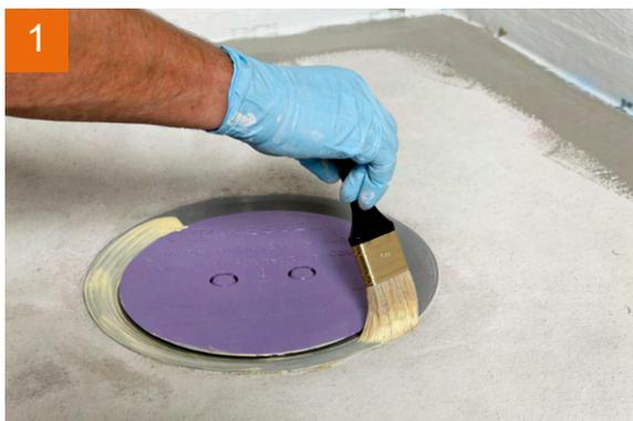
1 Grundierung des Flansches mit **PCI Gisogrund 303** oder **PCI Gisogrund 404**.
