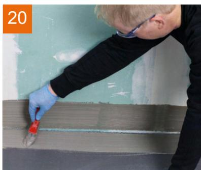
Abdeckung entfernen und im Randbereich **PCI Seccoral 1K** oder **PCI Seccoral 2K Rapid** vorlegen.
