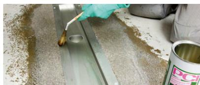
Nach dem Einbetten der Ablaufrinne im hoch wasserbeanspruchten Bereich mit Epoxidharz-Mörtel wird der Klebeflansch mit der Epoxidharz-Grundierung
