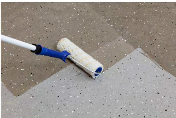
Bild: Auftrag einer Imprägnierung
