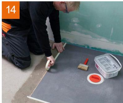
Tipp: Kleben Sie den schallentkoppelnden Randdämmstreifen mit einem Klebeband ab. Dann kann dort nichts dazwischenlaufen.
