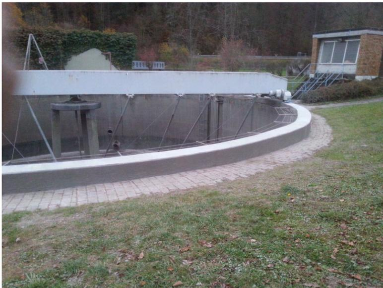
Bild: Räumlerlaufbahn in einer Kläranlage
