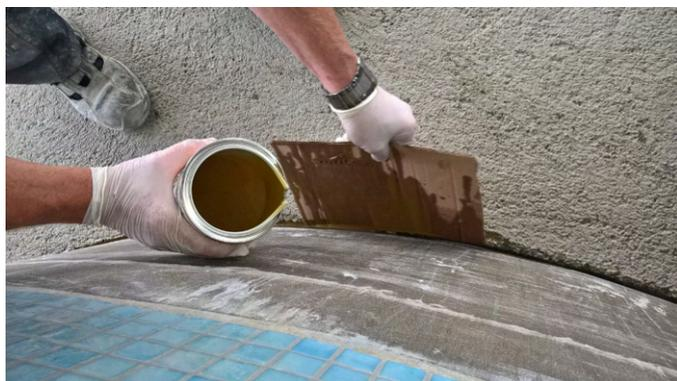
Bild: Fugenverguss zwischen Wand und Estrich
