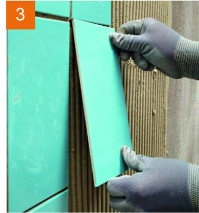
3 ... und die Fliesen ansetzen und ausrichten. Buttering-Floating-Verfahren erforderlich.
