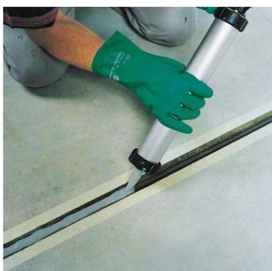
Bild: Ausführung einer Hochbaufuge
