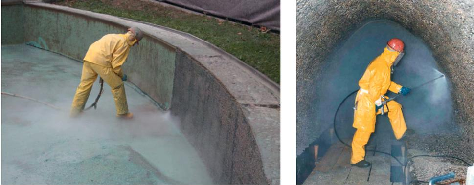
Der Betonabtrag geschieht erschütterungsfrei, sodass zu erhaltende Bereiche von potenziellen Rissen durch Erschütterungen verschont bleiben.
