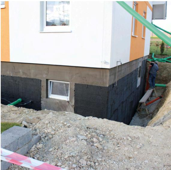
Bild: Erstellung einer erdberührten Bauwerksabdichtung
