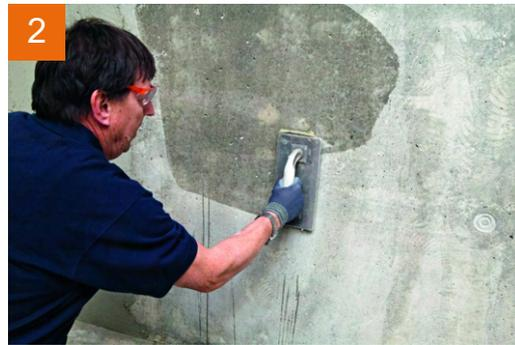
2 Zur Regulierung des Saugverhaltens den Untergrund leicht anfeuchten oder abhängig von der nachfolgenden Anwendung mit [PCI Gisogrund](#) oder [PCI Gisogrund 404](#) grundieren.
