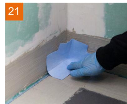
Vorgefertigte Spezial-Innenecke **PCI Pecitape** ...
