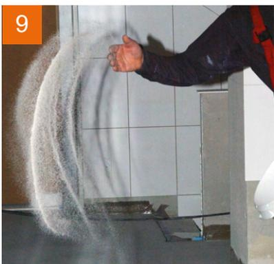
Zur besseren mechanischen Verkrallung mit dem Fliesenkleber **PCI Apoflex** vollsatt mit Quarzsand abstreuen.
