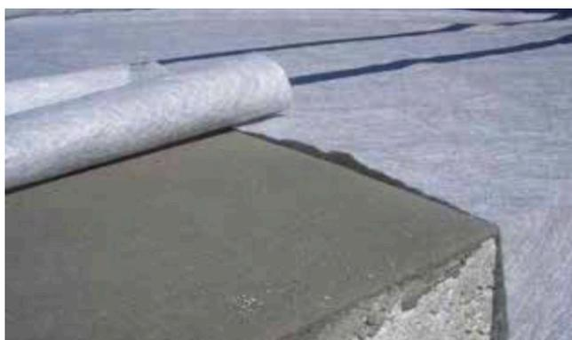
Bild: Abdeckung eines frischen PCI Nanocret R4 mit feuchtem Vlies
