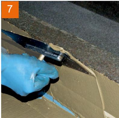
Anschließend noch einmal mit **PCI Apoflex** überarbeiten.
