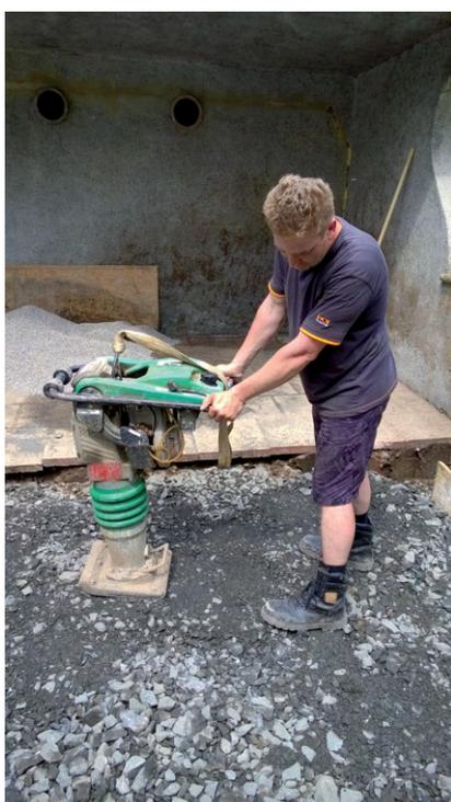
Erstellen einer verdichteten Kies-Schotter-Tragschicht:
