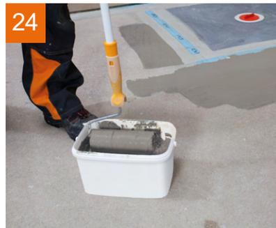
24 Anschließend Ausführen der Flächenabdichtung: 1. Auftrag mit **PCI Seccoral 1K** oder **PCI Seccoral 2K Rapid**
