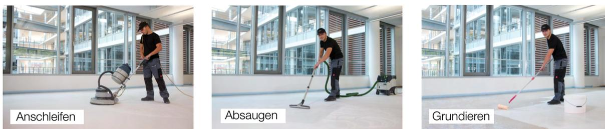
In Verbindung mit Holzdielen gilt prinzipiell das zuvor Beschriebene. Konstruktionsbedingt sind diese jedoch zuvor mit geeigneten Holzschrauben mit durchgängigem Gewinde festzusetzen und danach anzuschleifen und abzusaugen. Zur Grundierung empfiehlt sich [THOMSIT R 790 Füllgrundierung](#), weil sich damit zwei Arbeitsschritte in einem Durchgang erledigen lassen: die notwendige Fugenverfüllung und das Grundieren der Fläche.
