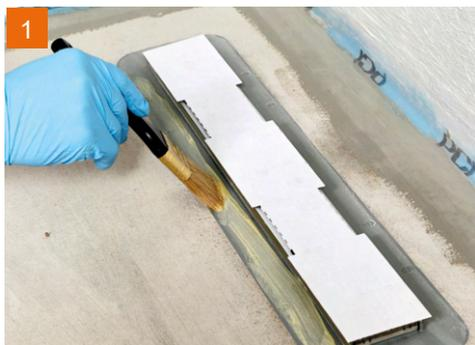
1 Grundierung des Anschlussflansches mit **PCI Epoxigrund 390**.
