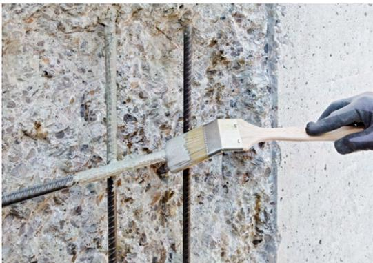
Bild: freigelegte Bewehrung, entrostet, wird mit Korrosionsschutz versehen
