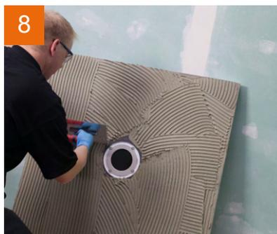
Zunächst eine Kratzspachtelung auf dem Unterbau und der Rückseite des **PCI PowerBoard** ausführen, den Kleber aufkämmen...
