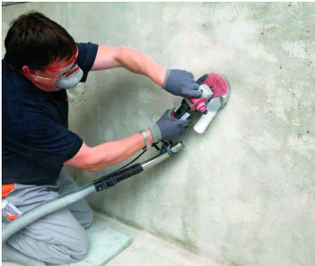
Ziel ist es, durch den Abtrag von nicht ausreichend tragfähigen Schichten wieder auf ein tragfähiges Korn zu kommen. Sind die Oberflächen besonders rau, empfiehlt es sich, diese zunächst anzufräsen. Im Anschluss wird die Fläche mittels Kugelstrahlen überarbeitet, sodass die Gefügestörungen, die durch das Fräsen entstanden sind, beseitigt werden.
