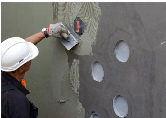
Bild: händischer Auftrag einer MDS
