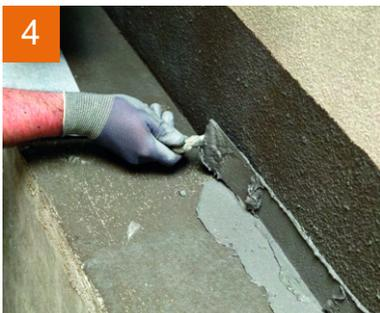
Zur Abdichtung von Kanten (zum Beispiel Wand- / Bodenanschlüssen) wird **PCI Seccoral 1K** oder **PCI Seccoral 2K Rapid** vorgelegt ...
