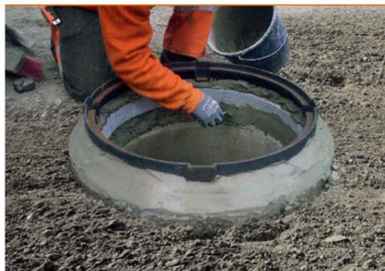
Diese Anforderungen erfüllen die Schnell-Zement-Mörtel **PCI Polyfix Plus**, **PCI Polyfix Plus L** und **PCI Polyfix Plus Fluid**.
