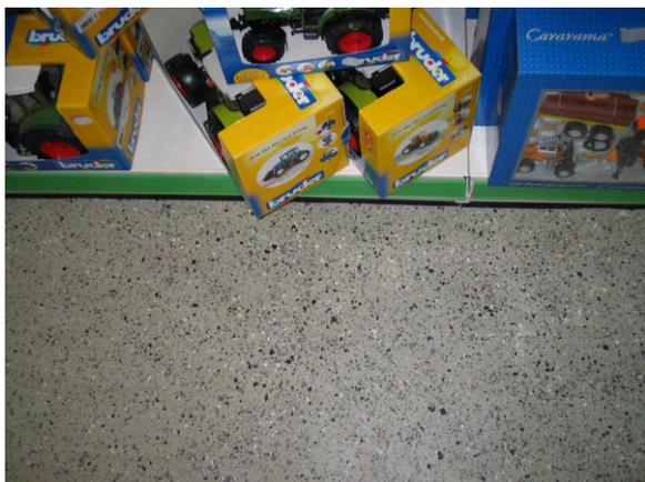
Bild: Verwendung von Farbchips bei einer Versiegelung
