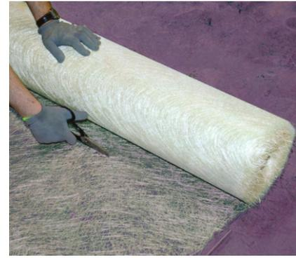
Das Glasfasergelege der **PCI Armiermatte GFM** mit einer Schere zurechtschneiden und auf dem grundierten Untergrund auslegen bzw. ausrollen.
