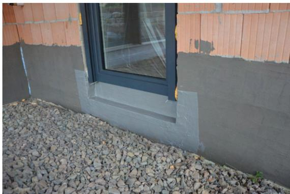
Bild: Abgedichteter Türanschluss mit Flüssigkunststoff **PCI Barraseal Ready** und **PCI Barraseal Vlies**
