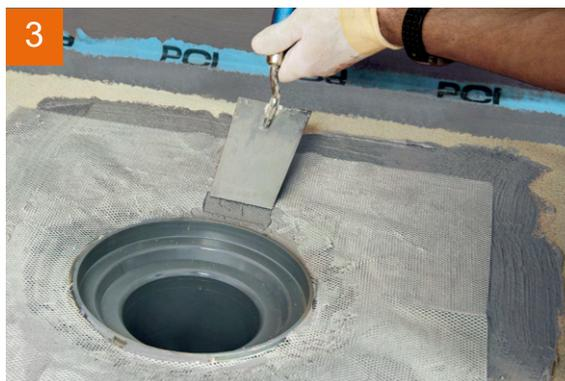
3 ...anschließend das Gewebe entsprechend dem Gefälleverlauf andrücken und mit **PCI Seccoral 1K** / **PCI Seccoral 2K Rapid** überarbeiten. Nach Durchtrocknung (ca. 1 Stunde) erfolgt der 2. Arbeitsgang mit **PCI Seccoral 1K** / **PCI Seccoral 2K Rapid**.
