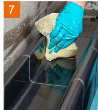
Sind die Rinnensteine gesetzt, kann nachfolgend zum Beispiel mit **PCI Durapox NT** / **PCI Durapox NT Plus** verfügt werden.
