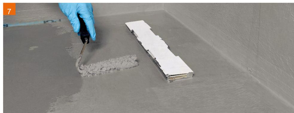
7 Nach einer Wartezeit von ca.1 Stunde erfolgt jeweils nächste Auflag bis zum Erlangen der Mindesttrockenschichtdicke von 2 mm.
