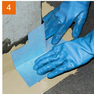
Formteile **PCI Pectatpe 90°** in die Abdichtungsschicht einlegen ...
