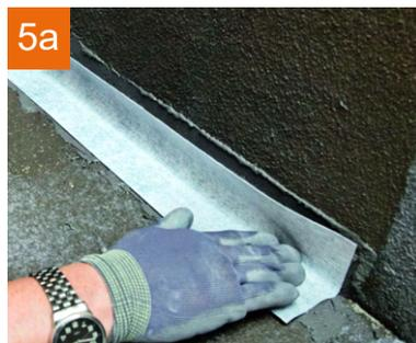
... dann das Abdichtband **PCI Pecitape** Objekt in die frische Dichtschlämme eingelegt und behutsam angedrückt. Die Ränder des Dichtbandes werden anschließend mit **PCI Seccoral 1K** oder **PCI Seccoral 2K Rapid** überarbeitet.
