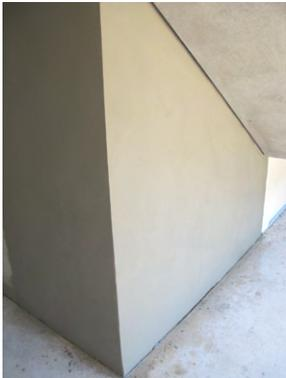
Eine weitere Möglichkeit, die insbesondere bei Flächen angewendet wird, um alte oder neue Betonbauteile in der Oberfläche strukturell anzugleichen, ist eine komplette Abspachtelung bis maximal 10 mm unter Verwendung eines nach EN 1504-3 geprüften Mörtels der Klasse R2 wie z. B. [PCI Nanocret FC](#).
