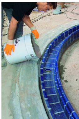
Das überfließende Wasser tropft bei fehlendem Verguss entweder in das Untergeschoss, oder es löst Kalk und Alkalisilikate aus dem Verlegemörtel der Fliesen des Beckenumgangs und transportiert diese mit der Zeit über die Kapillarporen der Fugen auf die Belagsoberfläche. Unansehnliche Kalk- und Silikatabscheidungen sind die Folge.
