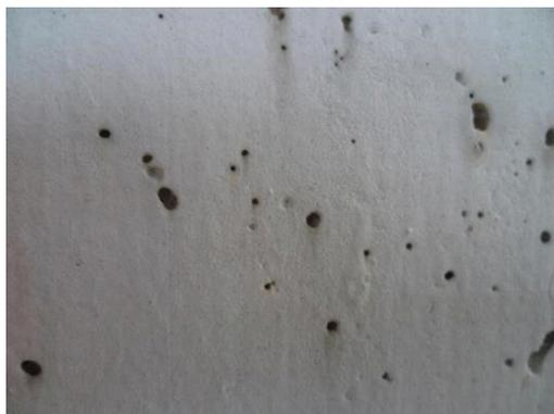
Beschichtungen im Sinne eines Oberflächenschutzsystems können in der Betoninstandsetzung Dispersionsfarben sein, die ohne vorherigen Auftrag eines Ausgleichsspachtels als OS 2 definiert werden oder mit Ausgleichsspachtel als OS 4 (OS C) bzw. OS 5a (OS DII) (rissüberbrückender Anstrich). Die Anwendung erfolgt im nicht begeh- oder nicht befahrbaren Bereich. Der Sinn der zuvor aufzubringenden Ausgleichsspachtelung liegt in einer möglichen Porenbildung an der Betonoberfläche.
