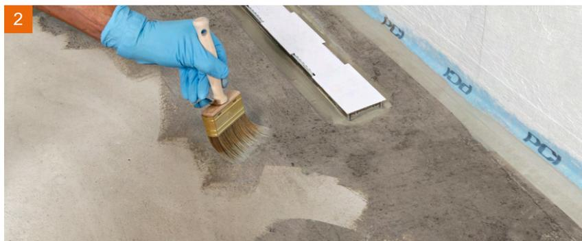
2 Die übrige Bodenfläche wird vorgenässt und mit verdünntem **PCI Seccoral 1K** / **2K Rapid** grundiert.
