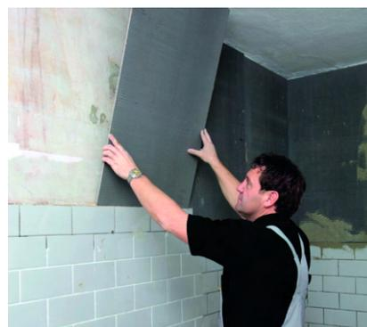
**PCI PowerBoard**-Element ansetzen und anschließend anklopfen.
