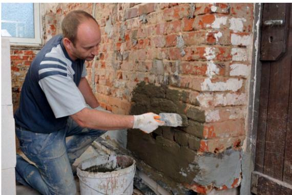
Bild: Auftrag einer nicht rissüberbrückenden MDS zur Innenabdichtung
