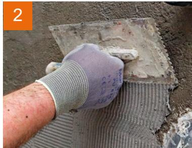
1. Auftrag **PCI Seccoral 1K** oder **PCI Seccoral 2K Rapid**. Ziehen Sie die Abdichtung mit einem Zahnpachtel (6 mm) auf ...
