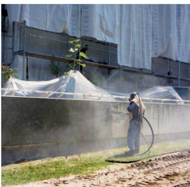
Dadurch werden haftungsfeindliche Oberflächenschichten entfernt bzw. die Oberfläche gereinigt und für die weitere Bearbeitung vorbereitet. Es gibt unterschiedliche Verfahren: Je nach Untergrund wird das Trockensandstrahlen oder das Feuchtsandstrahlen (sogenanntes Beton-Sandstrahlen) angewendet.
