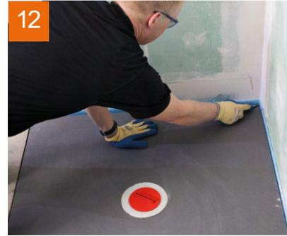
Den Randdämmstreifen bündig mit der Oberkante des **PCI PowerBoard** abschneiden.
