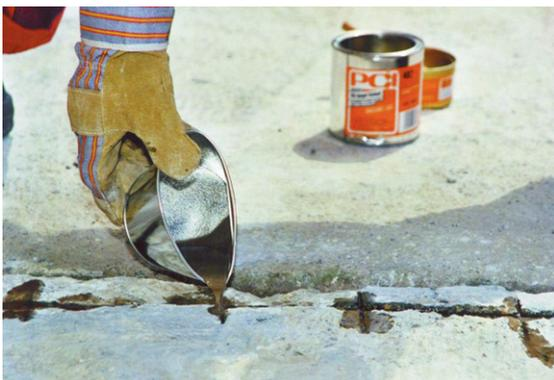
Bild: Risse verharzen mit [PCI Apogel F](#) [☞](#) und [PCI Estrichklammern](#) [☞](#)
