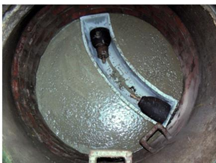
Bild: Einsatz von Kunststoffgerinnen in Verbindung mit zementären Mörteln
