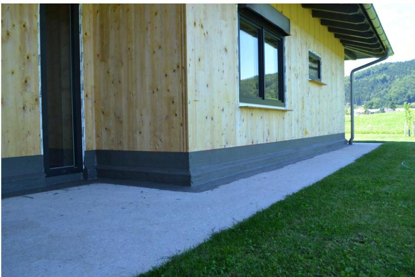
Bild: Sockelabdichtung im Holzbau
