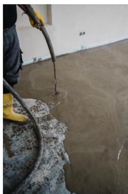
Bild: KSK als Horizontalabdichtung, Einbau eines Estrichs auf Trennlage
