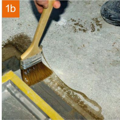
Details und Übergänge an Einbauteilen sowie Durchdringungen mit **PCI Epoxigrund 390** grundieren.
