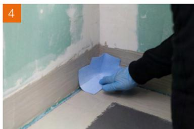
Einlegen der vorgefertigten Spezial-Innenecke **PCI Pecitape 90°** [↗](#) in **PCI Seccoral 1K** [↗](#) / **PCI Seccoral 2K Rapid** [↗](#).
