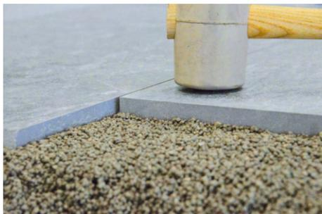
Diese Verlegevariante ist eine sogenannte Mischbauweise und mit dem Bauherrn vertraglich zu vereinbaren. Die ungebundenen Oberbauschichten bestehen aus der zuvor beschriebenen fachgerechten Frostschutz- und Tragschicht. Der darauffolgende Aufbau aus Drainmörteln und Kontaktschichten ist gebunden. Bei sorgfältiger Ausführung lassen sich Schäden aus Setzungen vermeiden.
