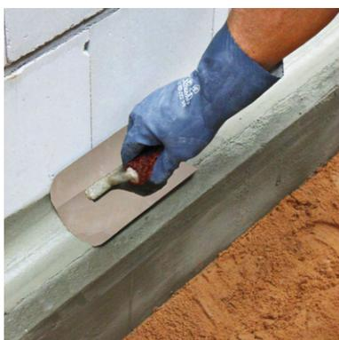
Bild: Erstellen einer Hohlkehle mit [PCI Polyfix Plus L](#)
