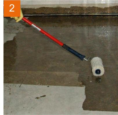
Untergründe vorbereiten, Verunreinigungen und nicht tragfähige Bereiche entfernen und ausgleichen. Mit **PCI Epoxigrund 390** grundieren.
