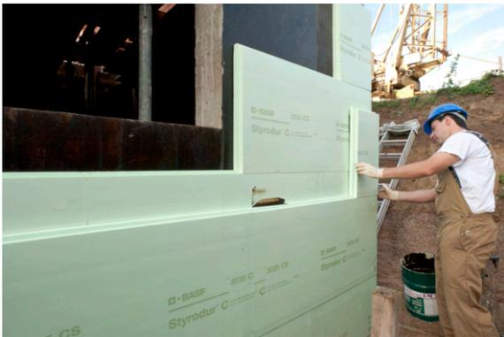
Bild: Verkleben von Schutz- und Dämmmaterialien
