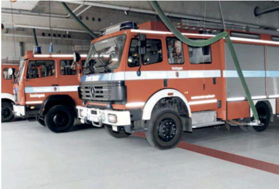
Bild: Fahrzeughalle mit OS-8-System
