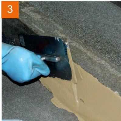
Vor dem Verkleben der Abdichtbänder wird **PCI Apoflex** vorgelegt.
