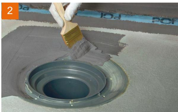
2 **PCI Seccoral 1K** / **PCI Seccoral 2K Rapid** vorlegen ...
