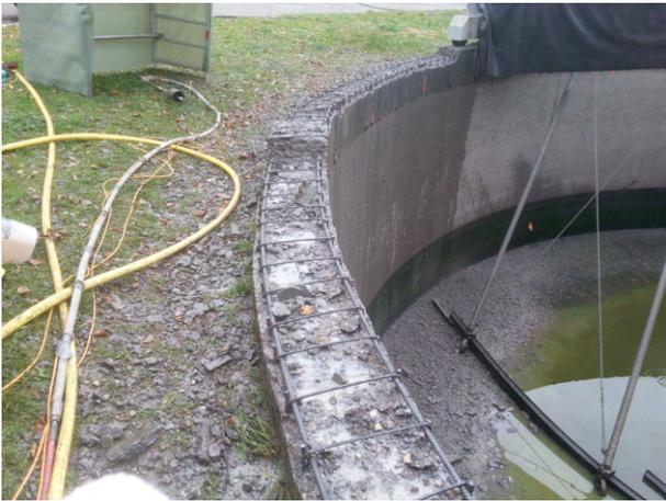
Bild: Klassische Betoninstandsetzung im Abwasserbereich
