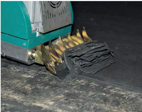
An der Vorderseite der Maschine befindet sich eine Klinge, die sich unter den Teppich schiebt und den Belag löst.
