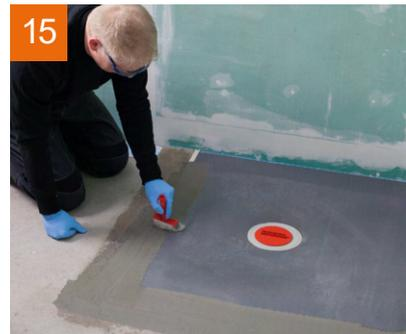
**PCI Seccoral 1K** oder **PCI Seccoral 2K Rapid** als Kleber für die Abdichtbänder vorlegen...
