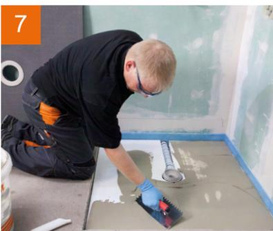
Fliesenkleber aufziehen, um das **PCI PowerBoard** mit dem Unterbaulement zu verkleben.
