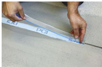
**PCI Pecitape Protect** schützt das Dichtband vor mechanischer Beschädigung, z. B. beim Herausschneiden von wartungsbedürftigen Silikonfugen
