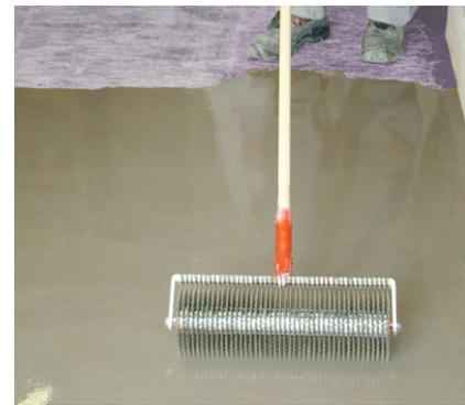
... und mit einer geeigneten Stachelwalze entlüften.
