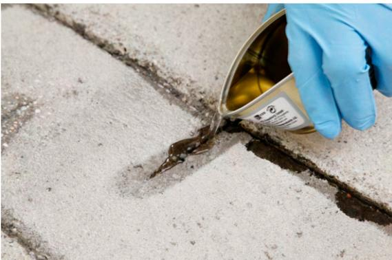
Bild: Rissanierung durch Vergießen mit einem niedrigviskosen Harz
