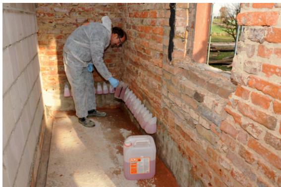
Bild: Erstellen einer chemischen Horizontalabdichtung
