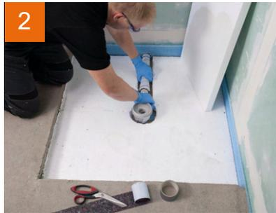
Der Ablauftopf wird an das vorhandene Ablaufrohr angeschlossen ...
