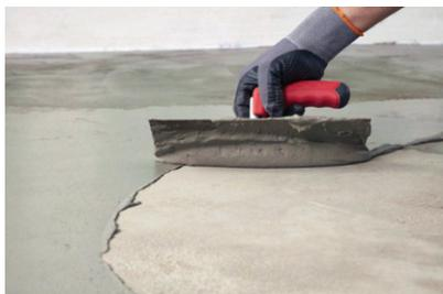
Flächenabdichtung mit **PCI Seccoral 2K Rapid**
