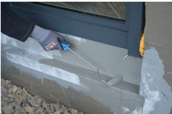
Bild: Überarbeiten des eingelegten Systemvlies mit **PCI Barraseal Ready**
