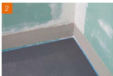
Anschließend wird zum Verkleben des Sicherheits-Dichtbands **PCI Pecitape 120** [↗](#) das Abdichtungsmaterial **PCI Seccoral 1K** [↗](#) / **PCI Seccoral 2K Rapid** [↗](#) an der Wand vorgelegt.
