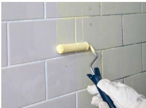
Die Verlegetechnik „Fliese auf Fliese“ ist eine schnelle und einfache Methode, um in der Sanierung einen Belag zu erneuern. Im Bodenbereich muss sichergestellt sein, dass die erforderlichen Aufbauhöhen zur Verfügung stehen oder dass Höhenversätze zu angrenzenden Belägen sicher angeglichen werden können. Voraussetzung ist die sichere Anhaftung des Altbelags zum Untergrund. Hohlliegende Platten müssen entfernt und Lunker sowie Ausbruchstellen mit Mörtel (z. B. **PCI Pericret**) aufgefüllt werden.
