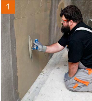
1 Kratzspachtelung mit **PCI FT Klebemörtel** vergütet mit **PCI Lastoflex** ausführen.
