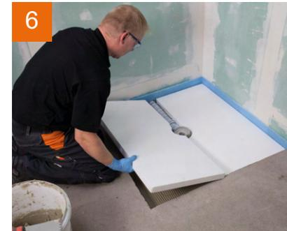
Die Platten werden untereinander mit einem Klebemörtel, zum Beispiel **PCI Flexmörtel S1**, verklebt. Tipp: Höhe der Estrich-Konstruktion – Randstärke **PCI PowerBoard** – 5 mm für Fliesenkleber = Stärke der EPS-Platten
