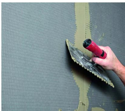
Die Plattenstöße und Anschlüsse werden mittels Klebemörtel beigespachtelt. Bei Bedarf kann auch zusätzlich ein Glasgewebe, z.B. **PCI Gewebbahn**, eingespachtelt werden.
