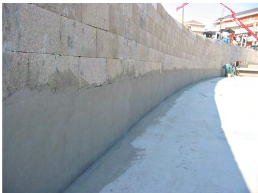
Bild: flächiges Verschließen von Fehlstellen /
