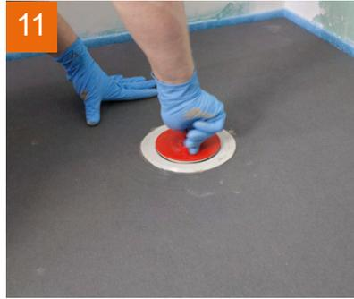
... anschließend das **PCI PowerBoard** mittels Baustopfen fest mit dem Bodenablauf verschrauben. Der Baustopfen stellt sicher, dass der Bodenablauf durch nachfolgende Arbeitsgänge nicht verunreinigt wird.
